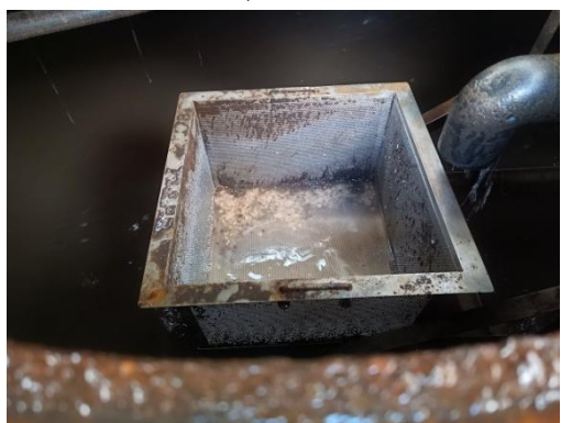
รูปที่ 2-26 จัดให้มีตะแกรงดักขยะภายในบ่อตรวจคุณภาพน้ำ
