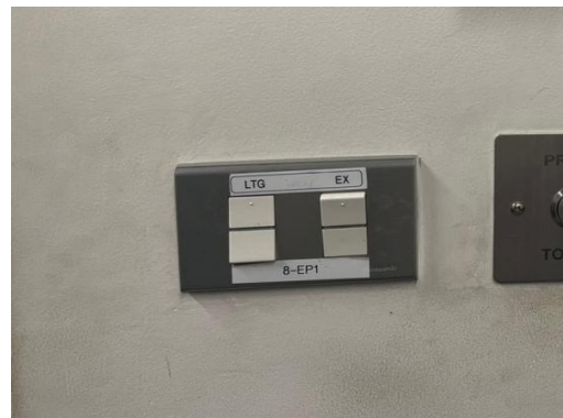
รูปที่ 2-40 แยกสวิตช์ควบคุมไฟฟ้าส่องสว่าง
