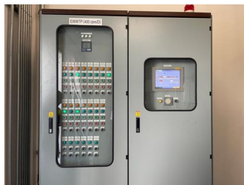
รูปที่ 2-24 ตู้ควบคุมระบบบำบัดน้ำเสีย และมีมอเตอร์ไฟฟ้า สำหรับระบบบำบัดน้ำเสียโดยเฉพาะ
